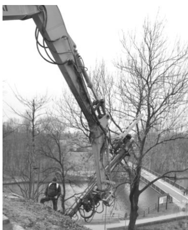
Rys. 2. Wykonywanie kotew gruntowych na Wzgórzu Zamkowym (zdjęcie: B. Piotrowicz). Fig. 2. Installing ground anchors on the Castle Hill (photo by B. Piotrowicz).
